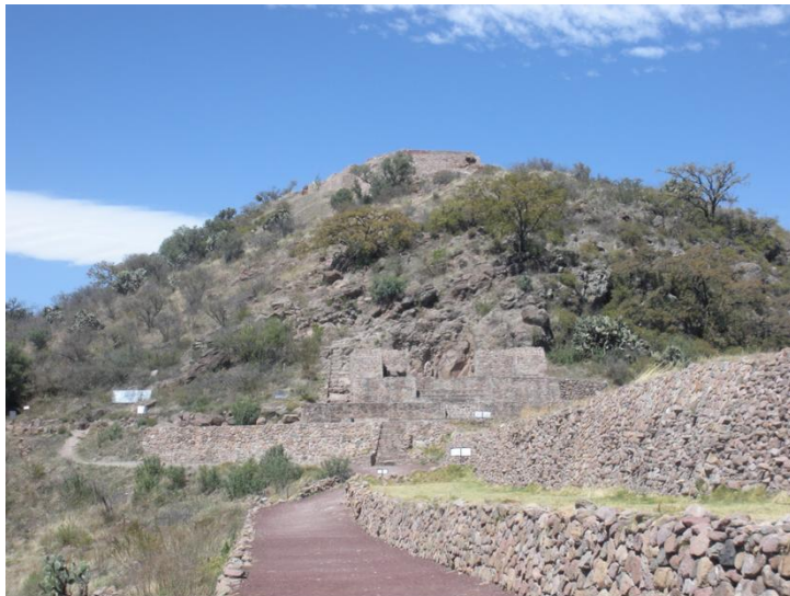
Acueducto y vista oriente de Tezcotzincó
